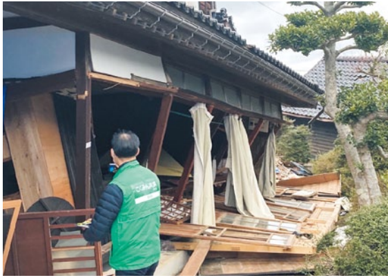
現場調査の様子
