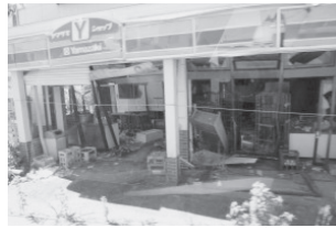
壊れたままの富岡駅前の商店街
